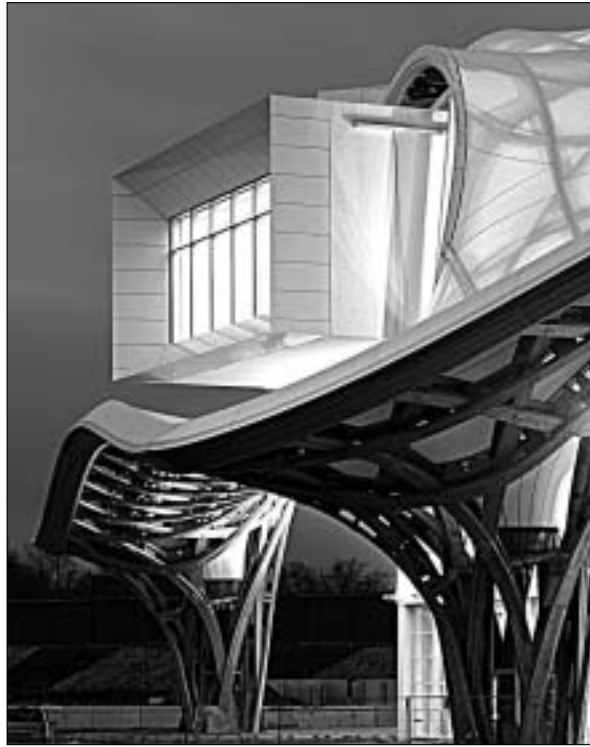
Centre Pompidou - Metz.
